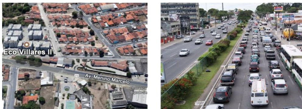
Figura 18: Imagem de satélite mostrando o bairro da Serraria (esq.) e fotografia da Av. Fernandes Lima no bairro do Farol (dir.)
